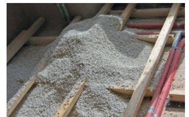
Einfach schütten und verfüllen
