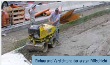
Einbau und Verdichtung der ersten Füllschicht
