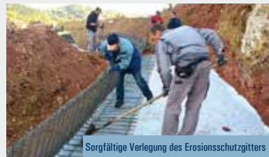
Sorgfältige Verlegung des Erosionsschutzgitters
