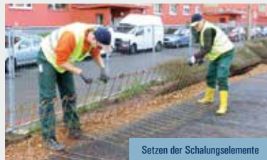
Setzen der Schalungselemente
