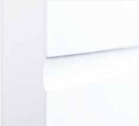
Detail Lucera: eingefräste Nut (Profiltiefe 1 mm)
